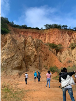
FIGURA II – Processo Erosivo na comunidade de Jenipapo, região do Cascalho.
